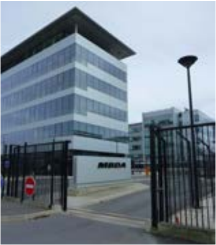
Siège et bâtiment process de MBDA par Stargime au Plessis-Robinson (92) Architecte ABH
