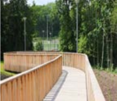
Passerelle des terrains de sport de l'ENPC à Champs-sur-Marne (77) Architecte Ateliers Lion Associés
