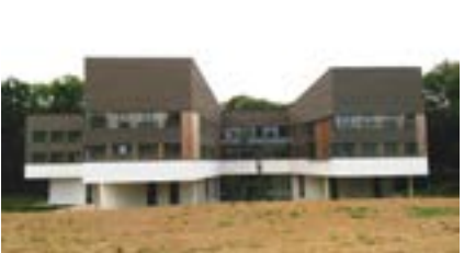
Internat du lycée Alexandre Denis à Cerny (91) Architecte Celnikier & Grabli
