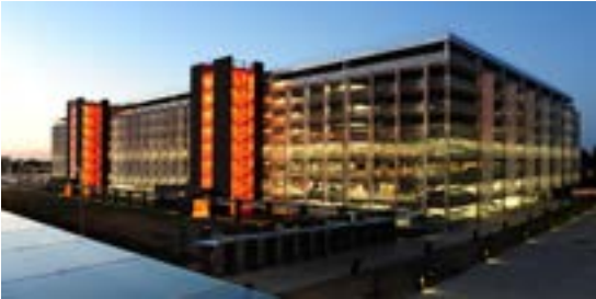
Parking aérien à l'Aéroport Toulouse Blagnac (31) Architectes SCAU - Azéma - Tsuba
