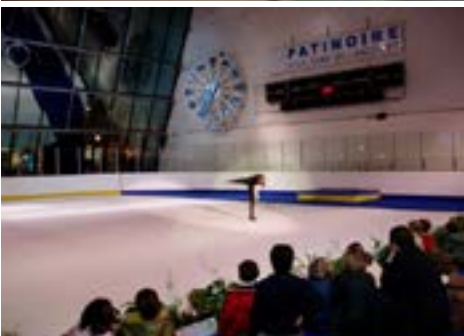
Rénovation et extension de l'ensemble piscine-patinoire de Boulogne-Billancourt (92) - Architecte TNA
