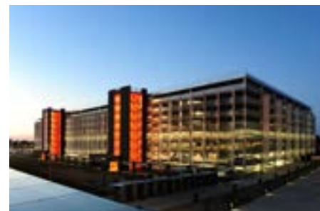
Parking de 3.200 places à l'Aéroport de Toulouse Blagnac (31) Architectes SCAU - Azéma
