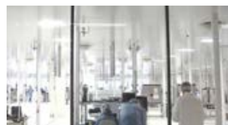
Salle à atmosphère contrôlée pour ELA Medical Groupe Sorin à Clamart (92) Architecte ABH
