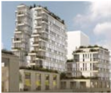
100 logements sociaux et école polyvalente à Paris 13 ème - Architectes Nicolas Reymond / Michel Guthmann Architecture Urbanisme
