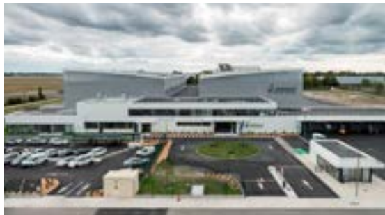
Hangar de maintenance des Falcon à Bordeaux Mérignac (33) Architecte Jean-Jacques Devilliers
