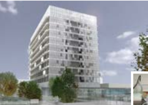
Réhabilitation des laboratoires de la Faculté de Médecine de l'Hôpital Necker à Paris 15 ème Architectes Henn Architekten – Patriarche & CO
