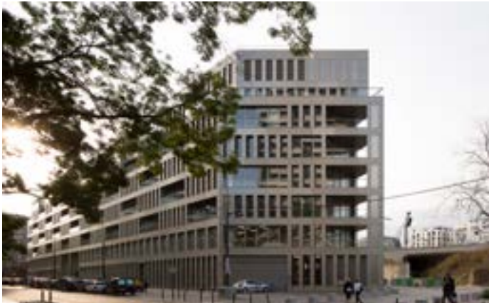
Bureaux - rue Gaston Tessier à Paris 19 ème pour Linkcity Architecte Ateliers 234
