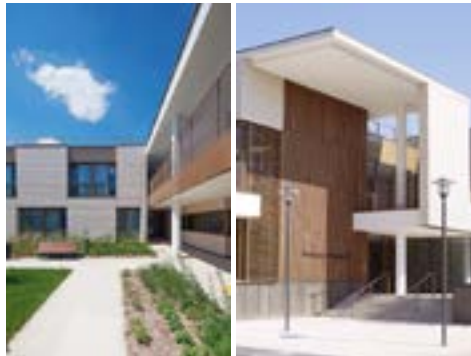
EHPAD pour le CASVP à Villers-Cotterêt (02) Architecte Lazo & Mure
