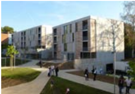
Logements sociaux à Mennecy (91) Architecte Jean Guevilly
