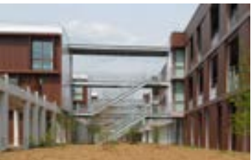
Lycée Bougainville à Brie-Comte-Robert (77) Architecte Ateliers 234
