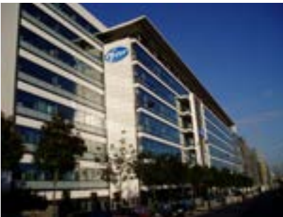
Immeuble Rives de Paris, siège social de Pfizer par Bouygues Immobilier à Montrouge (92) Architectes Mas & Roux – Saubot & Rouit
