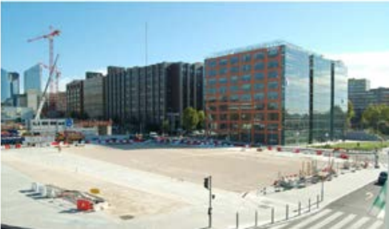
Aménagement de la Place de la Croisée des Axes Quartier Seine Arche à Nanterre (92) Architecte TGTFP
