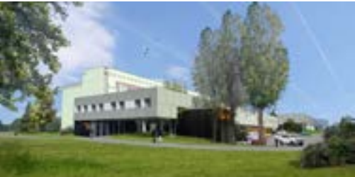
Bâtiment animalerie de l'INRS à Vandoeuvre-les-Nancy BMT & Associés Architecte
