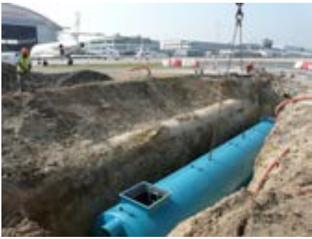
Pose de séparateurs d'hydrocarbures en zone réservée
