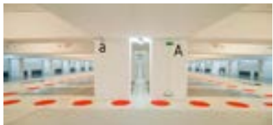
Restructuration du Parking souterrain MP10 Quartier Seine Arche à Nanterre (92) Architecte TGTFP
