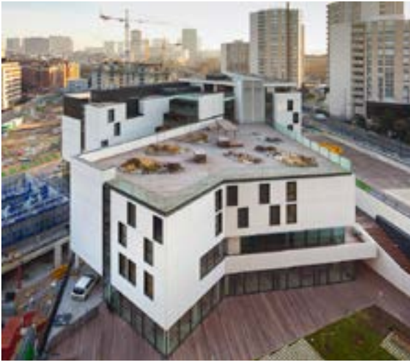
EHPAD Annie Girardot à Paris 13 ème Architecte Lazo & Mure
