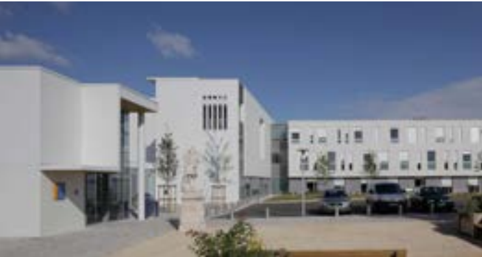
Pôle gériatrique du CHU de Poitiers (86) Architecte Lazo & Mure
