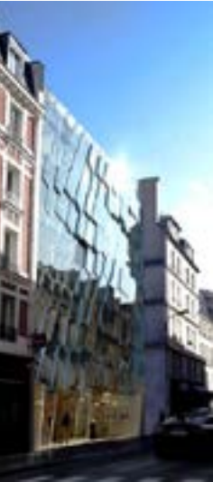
Extension de l'Institut de l'Audition à Paris 12 ème Architecte VIB Architecture
