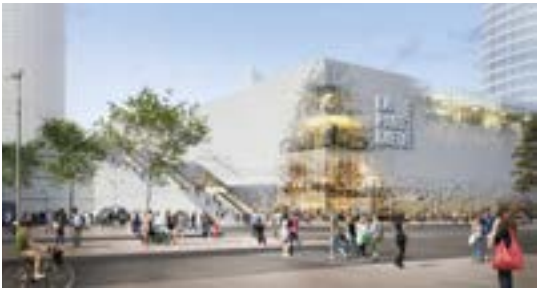
Centre commercial de la Part-Dieu à Lyon (69) Architecte MVRDV
