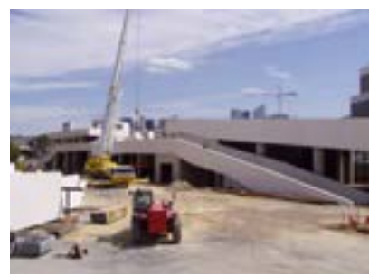
Viaduc Anatole France à Nanterre (92) Architecte TGTFP
