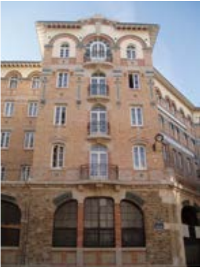
Rénovation du Palais de la Femme à Paris 11 ème Architecte A.X.C. IGREC INGENIERIE mandataire
