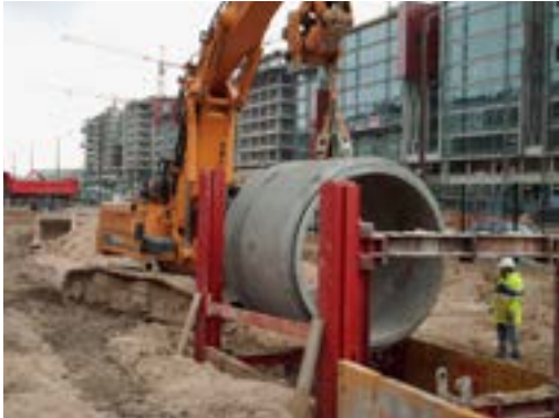
Travaux d'assainissement Quartier Seine Arche à Nanterre (92) Architecte TGTFP
