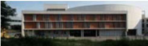
Bâtiments maternité et imagerie - Blocs opératoires Centre Hospitalier de Versailles Le Chesnay (78) Architectes Jean Dubus - Bernard Grimaux IGREC INGENIERIE mandataire
