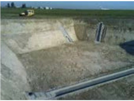
Création d'un bassin à ciel ouvert de 2 370 m³
