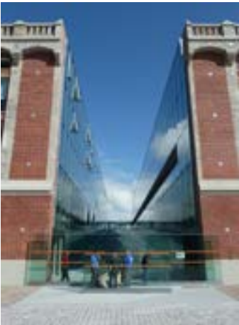
Halle aux sucres de Dunkerque (59) Architecte Pierre-Louis Faloci
