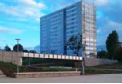
Passerelle piétonne dans le Parc François Mitterrand à Bagneux (92) Paysagiste Atelier de l'Ile
