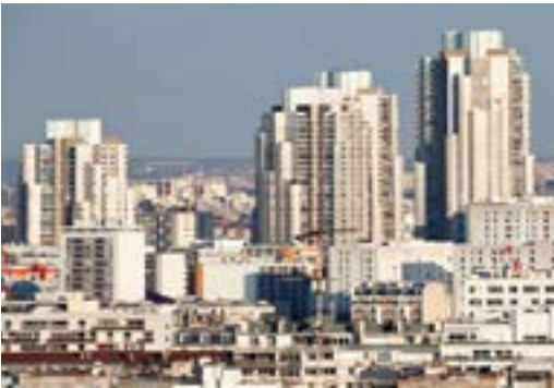
Réhabilitation des tours Prélude et Sonate à Paris 19 ème Architecte Ateliers Lion Associés
