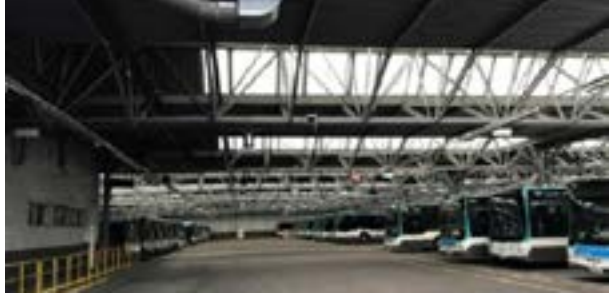
Dépôt de bus RATP au GNV à Thiais (94) Architecte Ferrand Sigal IGREC INGENIERIE mandataire
