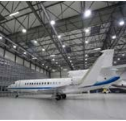
Hangar de maintenance pour le Falcon 7X de Dassault au Bourget (93) Architecte Jean-Jacques Devilliers
