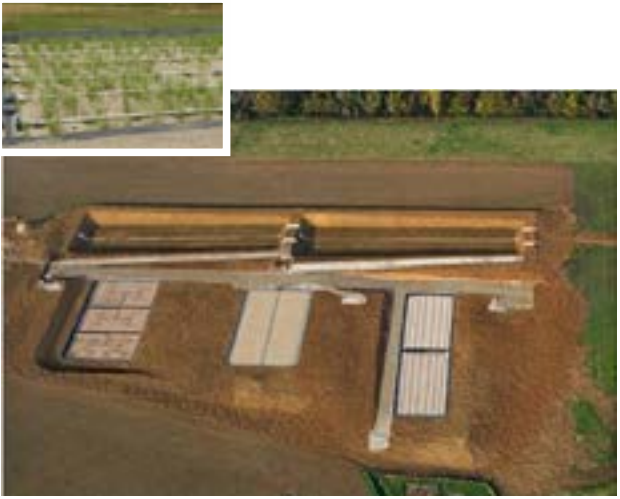
Filière alternative de traitement des eaux usées du lycée Bougainville à Brire-Comte-Robert (77) Architecte Ateliers 234
