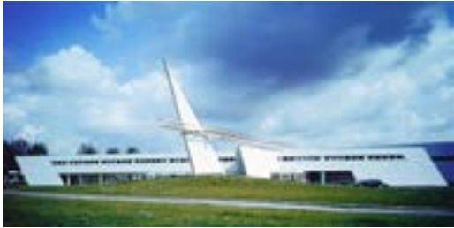
Usine CRMA, maintenance de matériel aéronautique par Sefri Cime à Elancourt (78) Architecte Patrice Novarina
