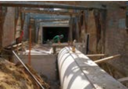
Construction d'une galerie technique et dévoiement de réseaux Groupe Hospitalier de la Pitié-Salpêtrière Paris 13ème IGREC INGENIERIE mandataire
