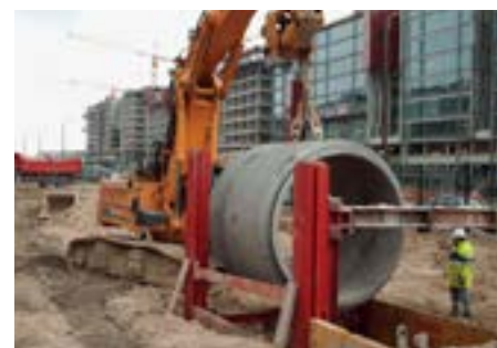
Travaux d'assainissement - Quartier Seine Arche à Nanterre (92) Architecte TGTFP
