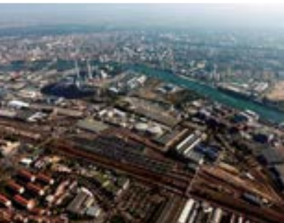
ZAC Gare Ardoines à Vitry-sur-Seine (94) Architecte TGTFP
